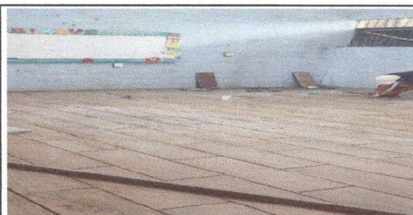
Foto 6: sustitucion de piso de torta de concreto por ceramico.
