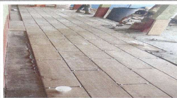
Foto 2: sustitucion de piso de torta de concreto por ceramico.
