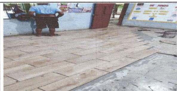
Foto 5: sustitucion de piso de torta de concreto por ceramico.
