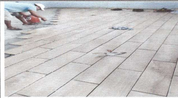
Foto 4: sustitucion de piso de torta de concreto por ceramico.
