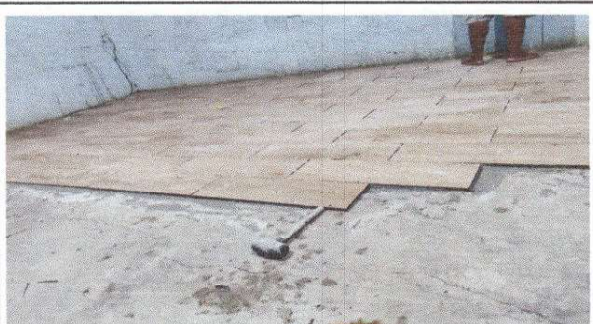
Foto 3: sustitucion de piso de torta de concreto por ceramico.
