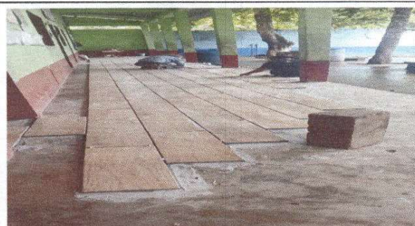
Foto1: sustitucion de piso de torta de concreto por ceramico.
